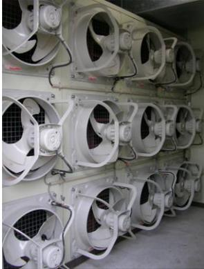
台車通過面全体に換気扇を設置し、
